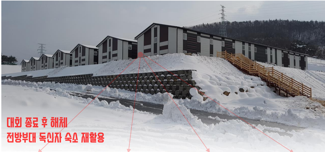
▼에스와이가 자사의 폴리캠하우스로 건설한 평창동계올림픽 선수지원단 숙소
